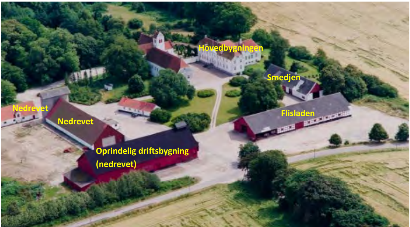
Figur 4.26: Luftfoto fra 1990 med de oprindelige driftsbygninger.
