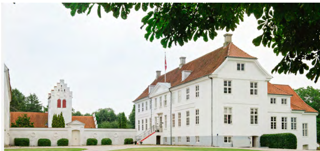
Figur 4.39: Hovedbygningen på Jomfruens Egede, samt kirkemuren og i baggrunden Øster Egede kirke.
